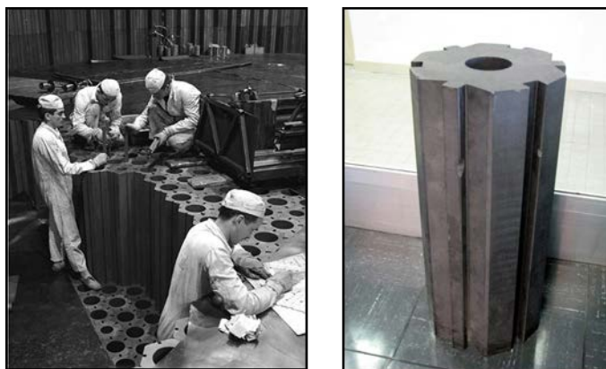
Figure 13 : Empilement en graphite
