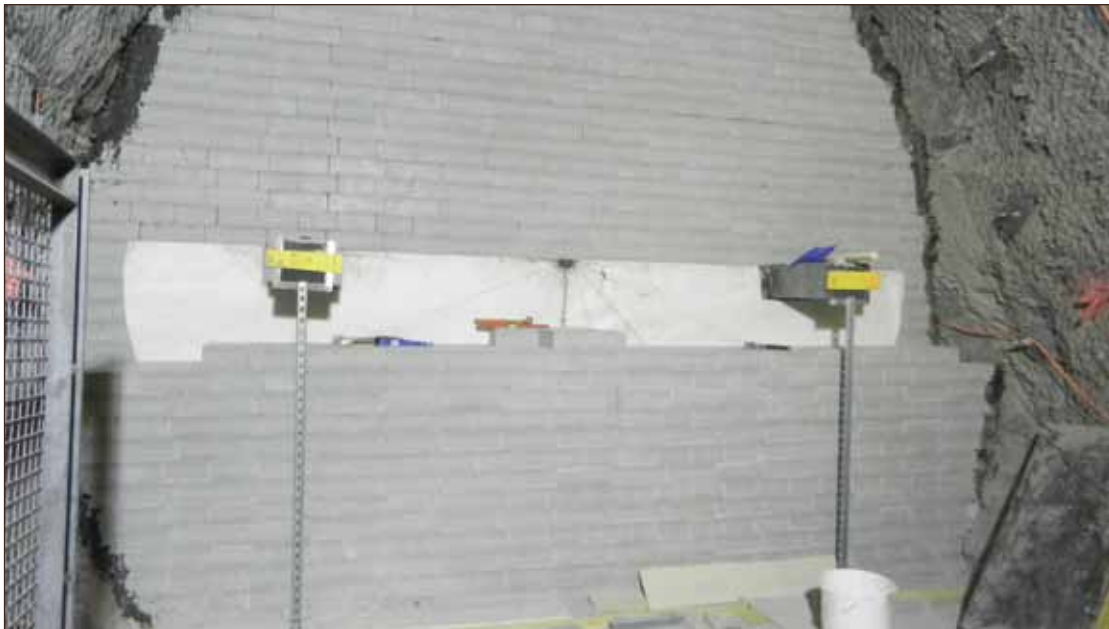
● Essai de montage d'un mur en briquettes d'argile gonflante et son instrumentation dans le laboratoire souterrain de l'Andra
