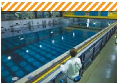
Après leur utilisation en réacteur, les combustibles usés sont entreposés dans des piscines remplies d'eau, afin qu'ils refroidissent. La hauteur d'eau permet d'assurer une protection contre les rayonnements qu'ils émettent.
