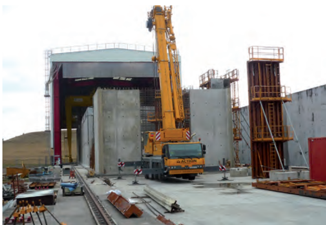
construction d'un ouvrage pour les couvercles
