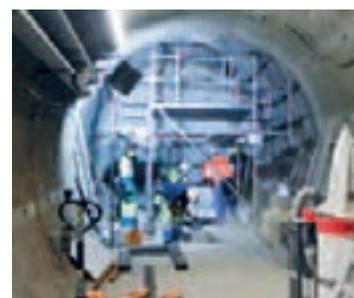
Mur de bentonite installé pour un essai de scellement dans le Laboratoire souterrain.
