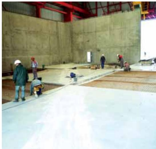
Un béton en pente est coulé sur le radier, de manière à diriger :
