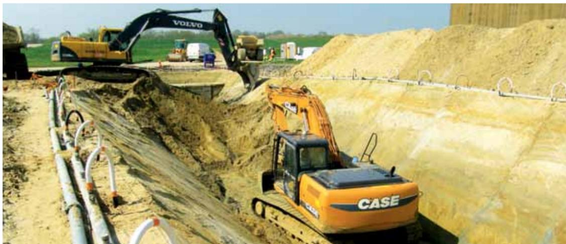
Ils visent à aménager le sol afin de préparer l'assise des ouvrages de stockage sur les sables de l'Aptien et la pose des éléments qui composent les galeries souterraines de surveillance.
