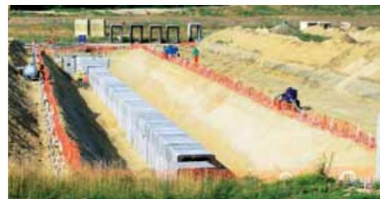
Creusées de part et d'autre des ouvrages, elles accueillent les canalisations qui serviront à recueillir les éventuelles eaux d'infiltration provenant des ouvrages de stockage. Durant cette opération, un rabattement de la nappe phréatique (abaissement du niveau de l'eau par pompage) est effectué afin d'assurer une mise hors d'eau pendant les travaux.
