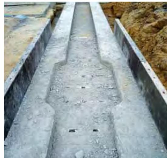
Afin d'accueillir les charpentes mobiles montées sur rail qui protégeront les ouvrages de stockage de la pluie pendant leur exploitation, des longrines (sorte de poutres en béton armé) sont réalisées de part et d'autre des ouvrages. Elles assurent le maintien des rails de transfert et l'arrimage des charpentes.
