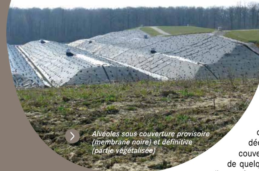
Alvéoles sous couverture provisoire (membrane noire) et définitive (partie végétalisée)
