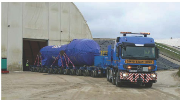
Stockage d'un générateur de vapeur de Chooz A en alvéole 13
