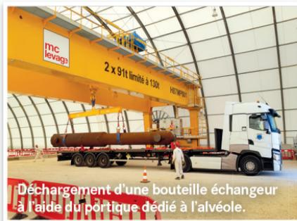
Déchargement d'une bouteille échangeur à l'aide du portique dédié à l'alvéole.
