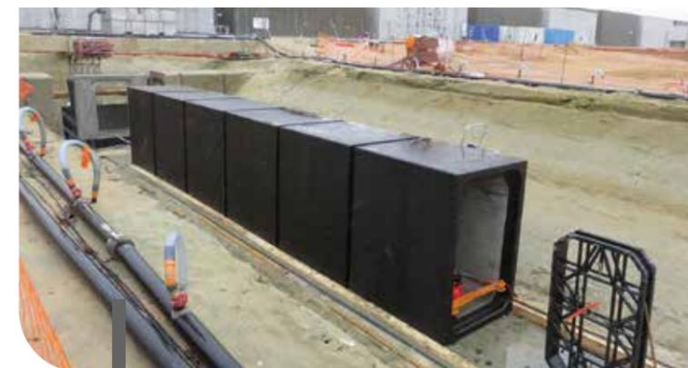
INSTALLATION DES ÉLÉMENTS EN BÉTON pour constituer les galeries souterraines de surveillance
