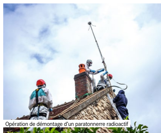
Paratonnerre disposant d'une source radioactive
