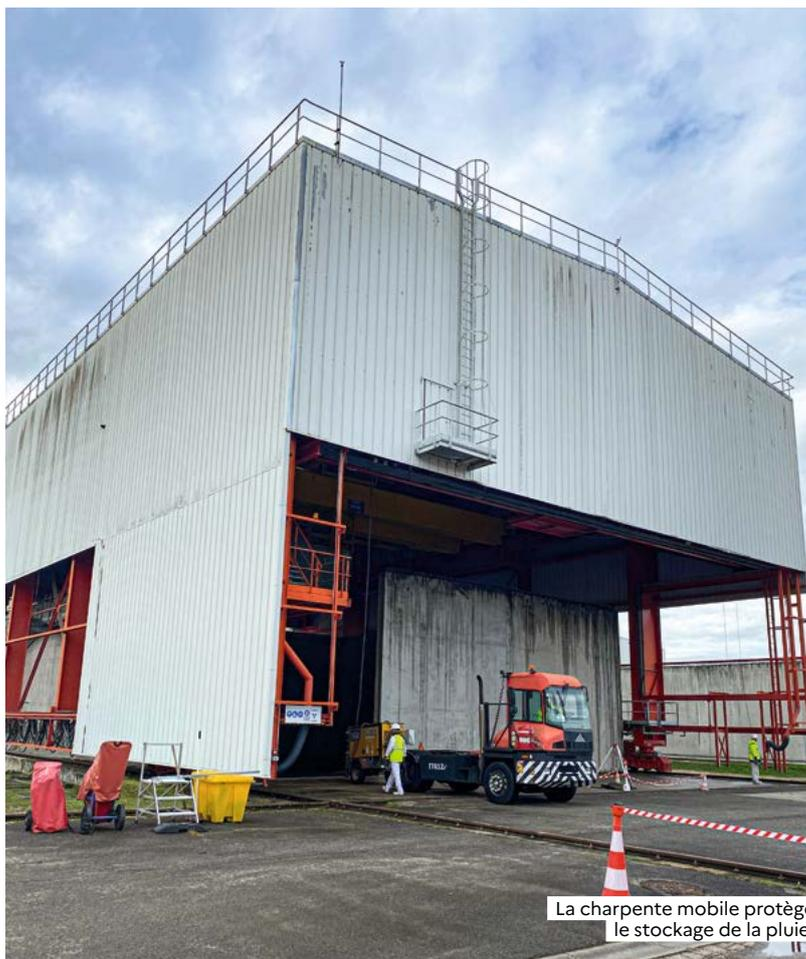
La charpente mobile protège le stockage de la pluie.
