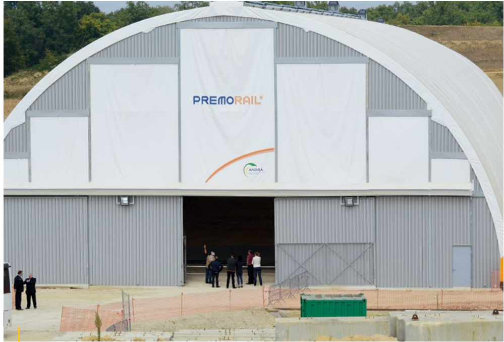
Les colis de déchets sont stockés à l'abri sous un Premorail®
