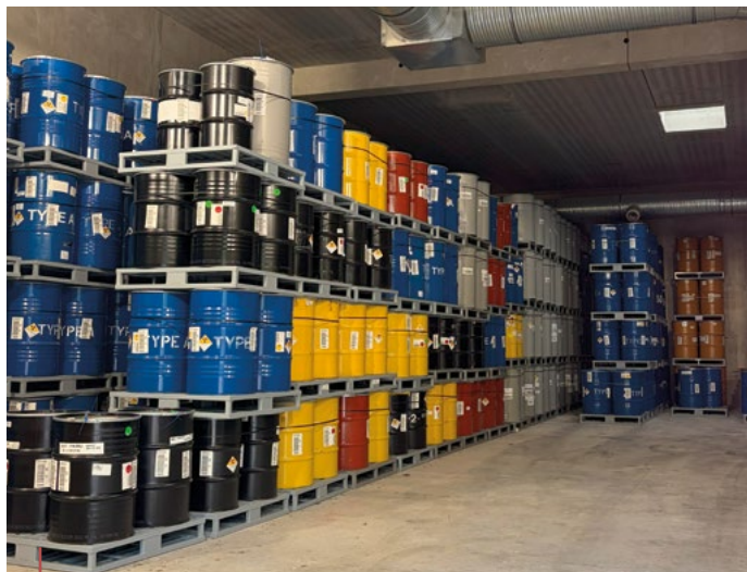
Colis de déchets présents dans le bâtiment d'entreposage du Cires
