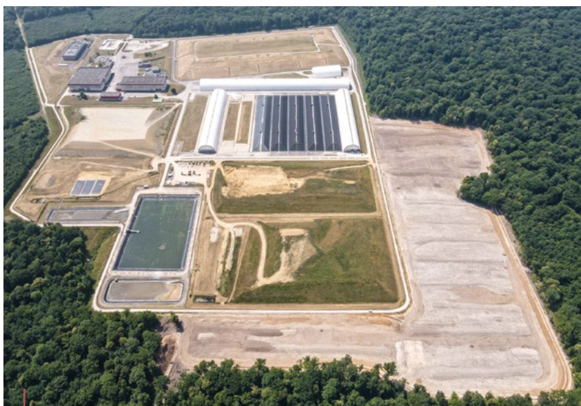
Vue aérienne du Cires avec la nouvelle plateforme de dépôt des terres (zone récemment déboisée à droite)
